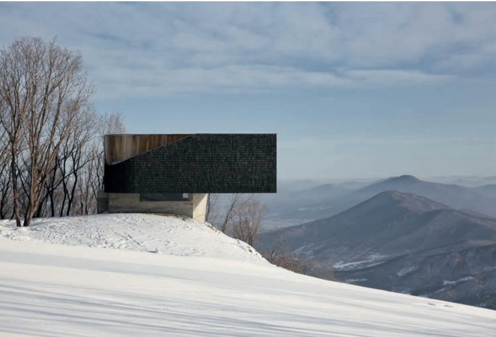
Het houten deel is bij z'n ronde tophoek op het relatief kleine betonnen onderstel gepind, zodat het vervaarlijk overhelt.
